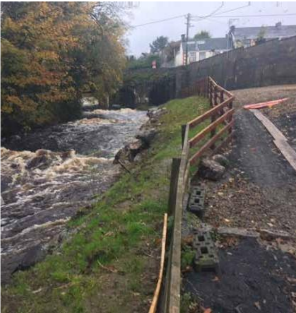
Tá Abhainn na Gráige in ardsreabhadh le sraith coraí cloiche ionsrutha agus armúr cloiche ar feadh neastaobh bhruacha na habhann.
