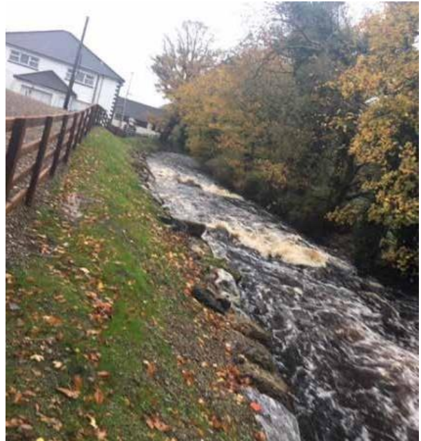
Tá Abhainn na Gráige in ardsreabhadh le sraith coraí cloiche ionsrutha agus armúr cloiche ar feadh neastaobh bhruacha na habhann.
