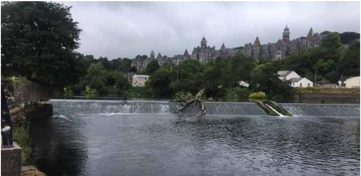
Radharc ar dheiscirt Chora na Laoi a thaispeánann pas éisc lárnach.
